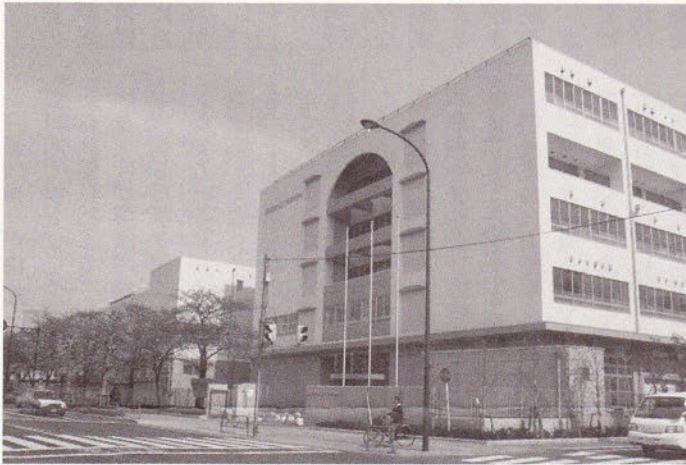
新設の都立六郷工科高等学校 校舎
