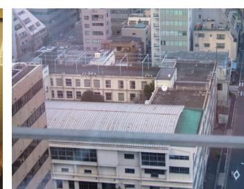
慈恵医大病院から撮影した、校舎解体前及び工事中 (通院中の港18A田中二昭様より提供)
