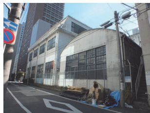
校舎裏(自動車工場)
